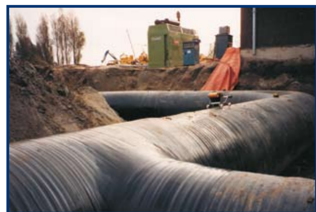
Bekleding van hulpstukken, zoals T-stukken, flenzen en afsluiters.
