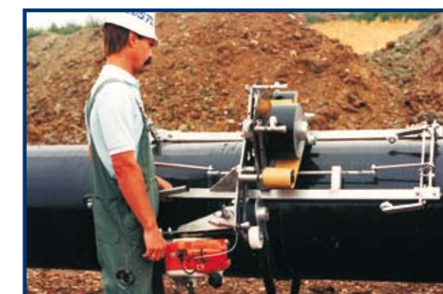
Verschillende soorten DENSOMAT-Wikkelmachines voor een snelle en doeltreffende verwerking van DENSOLEEN .
