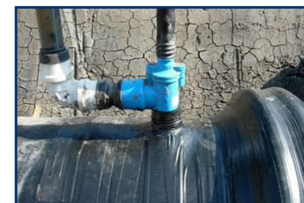
Water- en dampdichte afwerking van geïsoleerde leidingen.
