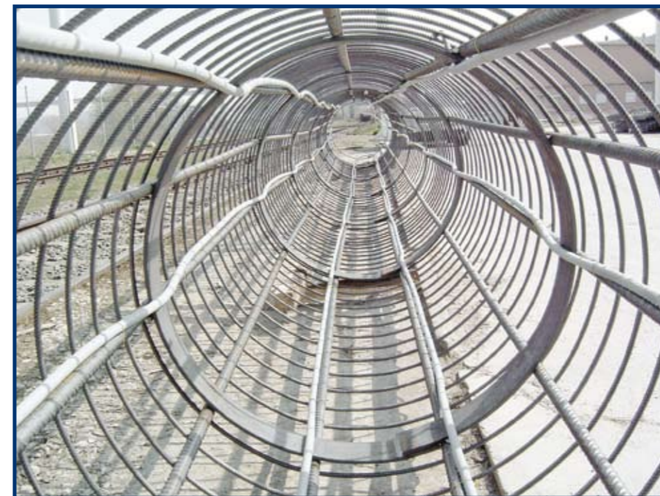
Energiekolom voor het plaatsen
