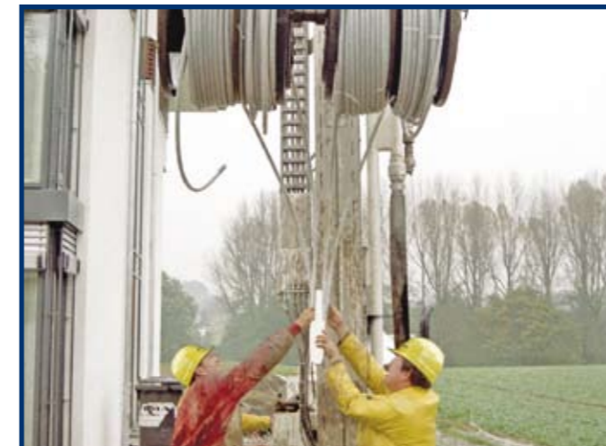
Inbouw van RAUGEO aardwarmtesonde
