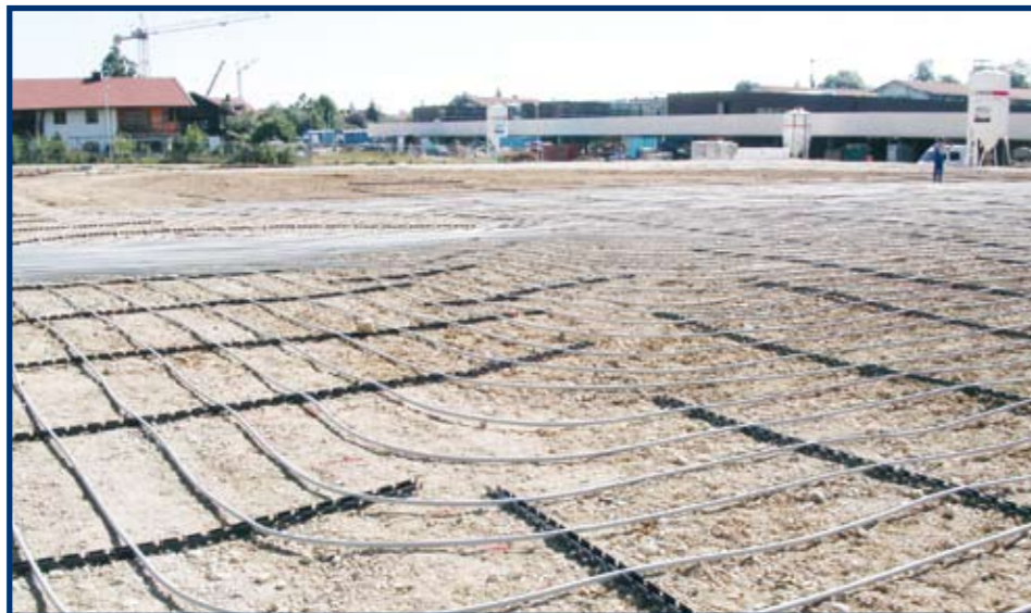
Plaatsing van RAUGEO aardwarmtecollectoren
