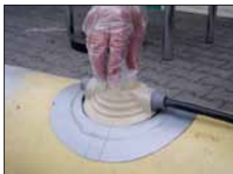
Foto 14 Als na korte tijd de giethars in alle holten van de kabel en de behuizing verdeeld is, de hars tot de onderkant van de invultuit bijgieten en het geheel met de afsluitkap sluiten.
