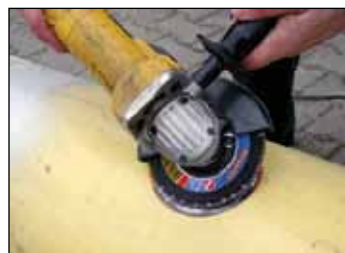
Foto 4 Bij PEHD- of PP-buisbekledingen de oorspronkelijke fabrieks-bekleding tot op het staaloppervlak verwijderen met een mechanische staalborstel.
