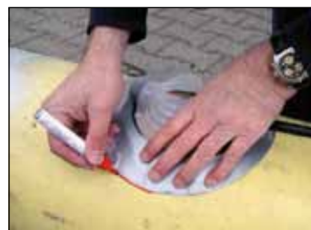
Foto 5 De behuizing (zonder de beschermfolie te verwijderen) op het buisoppervlak plaatsen en de buitenste rand van de plakrand markeren.
