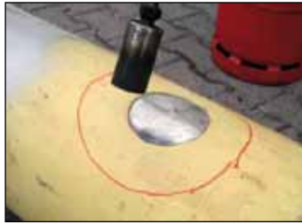
Foto 8 Met een laag ingestelde propaan-gasvlambrander de fabrieksbeleding drogen, echter deze mag niet warmer dan handwarm zijn.
