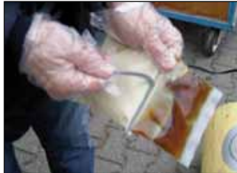
Foto 11 De aluminium verpakking van het zakje met giethars openscheuren, niet knippen of snijden. De scheidingsstrip uit de duokamerzak verwijderen.
