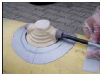
Foto 15 Met de bijgevoegde bevestigingsband de reservekabelbus op de buisbekleding bevestigen.
