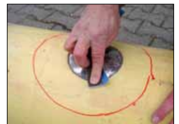
Foto 6 Met schuurpapier het gemarkeerde oppervlak van de fabrieks-bekleding zorgvuldig opruwen.
