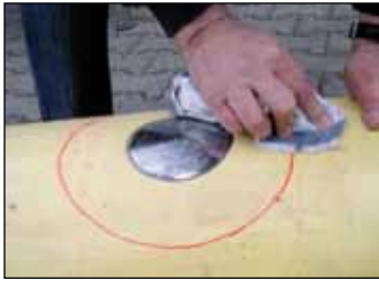
Foto 7 Met een schone doek het gemarkeerde oppervlak ontdoen van losse deeltjes, zodat het gebied waar de behuizing geplakt wordt, stofvrij is.
