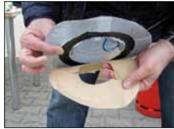
Foto 9 Nadat de kabel van buiten naar binnen in de kabeltuit is getrokken en gelast of gesoldeerd is op het buisoppervlak, de beschermfolie van de behuizing verwijderen, de behuizing op het buisoppervlak plaatsen en de plakrand - zonder vouwen - aandrukken.
