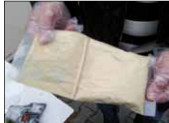
Foto 12 Door het kneden van het zakje de twee componenten met elkaar vermengen. De massa kneden totdat deze handwarm is. Een homogene massa is te herkennen aan een gelijkmatige kleur van de massa. Verwerkingstemperatuur +8°C - +40°C.
