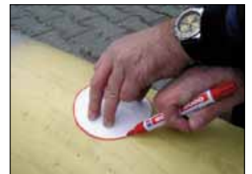
Foto 3 De mal op de plaats van de fabrieks-bekleding leggen waar de kabelaansluiting moet worden aangebracht. De buitenste rand met een stift markeren, daarna de fabrieks-bekleding tot de markering verwijderen.
