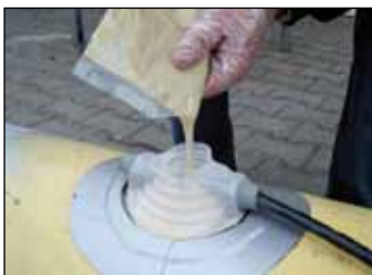
Foto 13 De hoek van het zakje afsnijden en de gietharsmassa langzaam, binnen de aangegeven tijd, in de behuizing gieten. De uithardtijd bedraagt ca. 5 - 6 minuten bij +20°C - +25°C.
