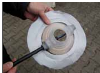
Foto 1 Het reeds geprepareerde kabeleind van buitenaf door de tuit trekken en in de behuizing invoeren, afhankelijk van het aansluitpunt.
