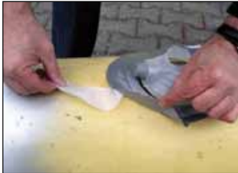
Foto 10 Alleen de buitenste verwijderbare folie van de plakrand verwijderen en de plakrand zonder vouwen aanbrengen.
