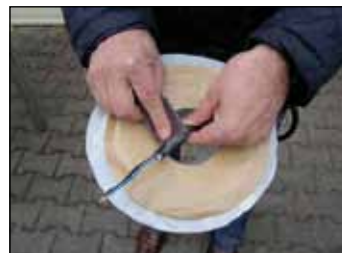
Foto 2 Het oppervlak van de kabelmantel, die zich in de behuizing bevindt met schuurpapier opruwen.
