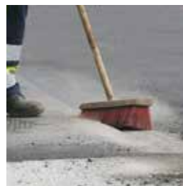
Voegflank reinigen en drogen
